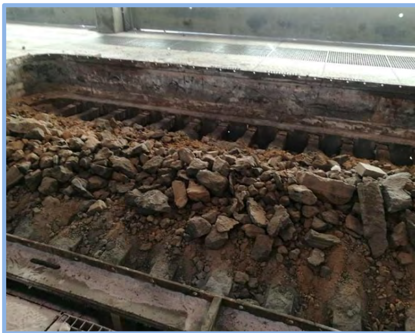
Fotografía 1: restos de la demolición de un fondo de cuba.
