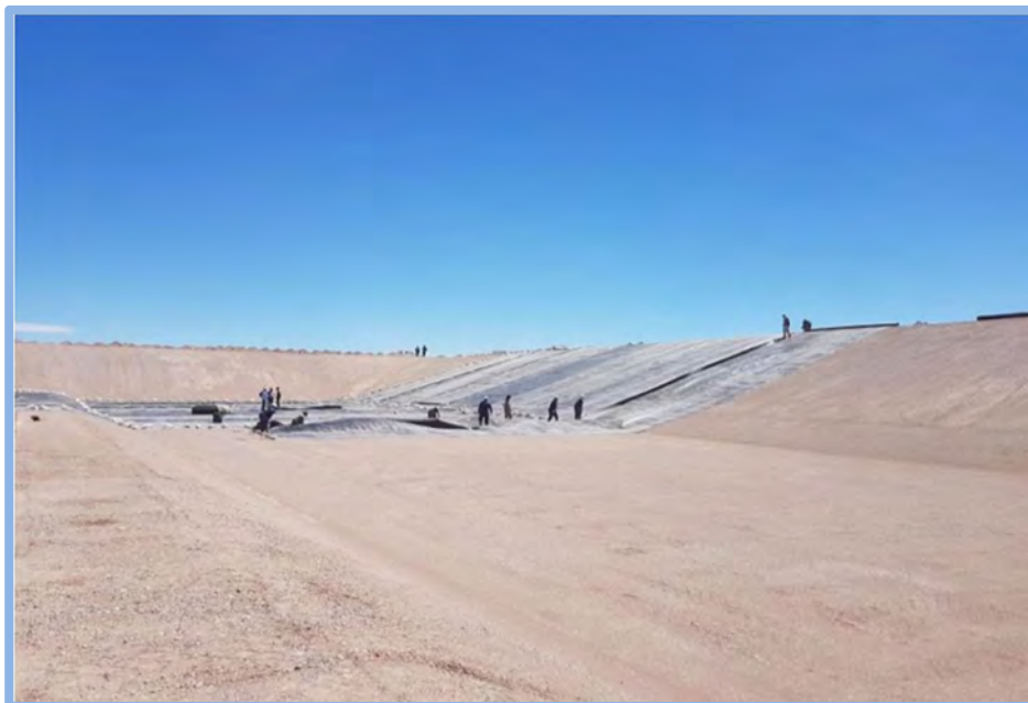
Ilustración 13: Imagen netamente ilustrativa del trabajo de colocación de membranas impermeabilizantes después de la primera barrera de arcilla y bentonita.
