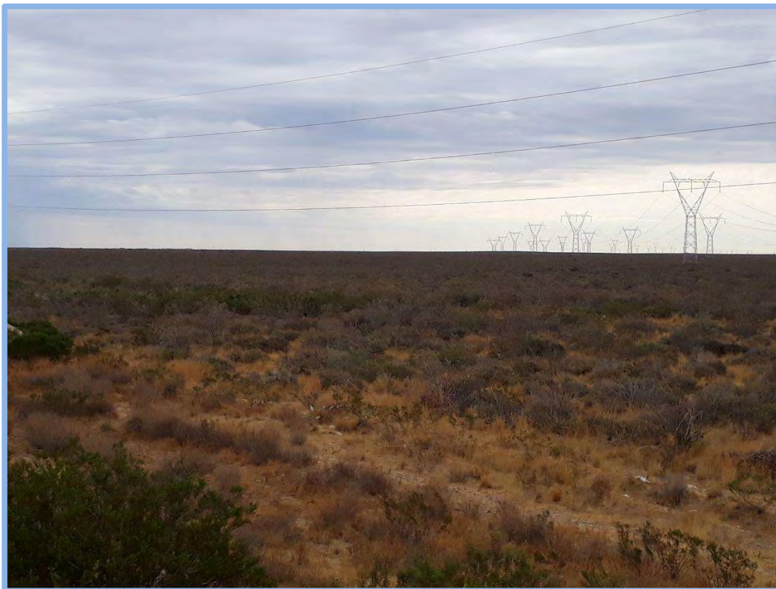
Fotografía 4: Vista general del Predio RSA, con vista hacia el sector a ocupar por el Relleno. Puede observarse la presencia de vegetación de pastizal y arbustiva baja.
